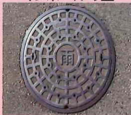
マンホールの蓋
